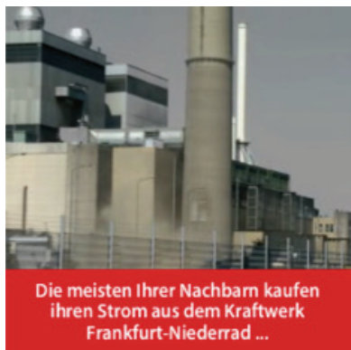
1. Motiv: regionales Kraftwerk
